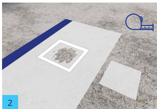
Nalepení opravné pásky okolo poškození.
