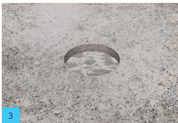
3 Ukázka pokládky na pilotu bez výztuže.
